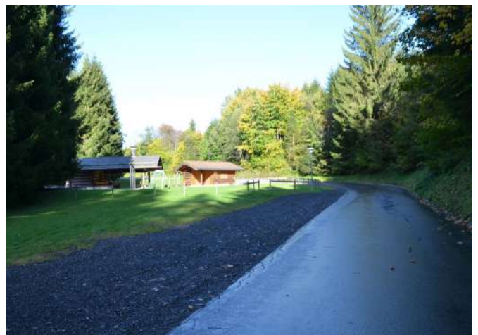
Blick auf Erschließungsstraße nach Obermaiselstein
