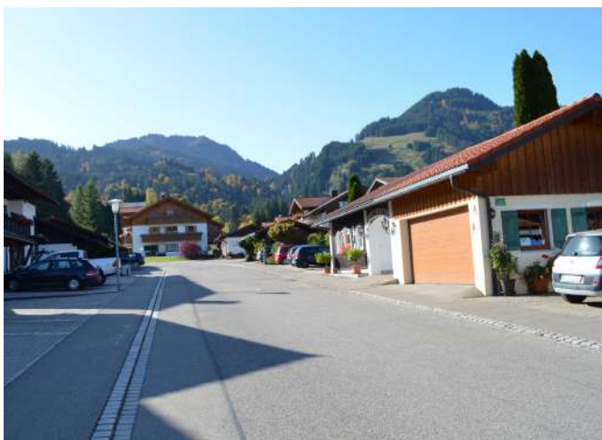
Beidseitige Gehwege mit Homburger Kante, Hoistai
