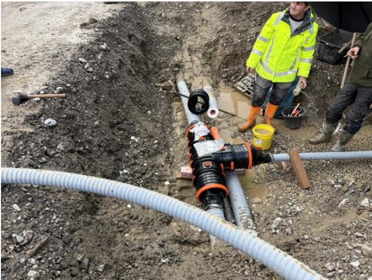
Wärmehauptleitung mit Hausanschluss am 12.05.2026
