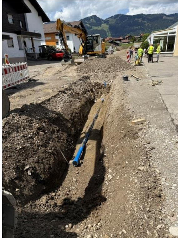
Verlegung der Hauptwasserleitung am 19.05.2026
