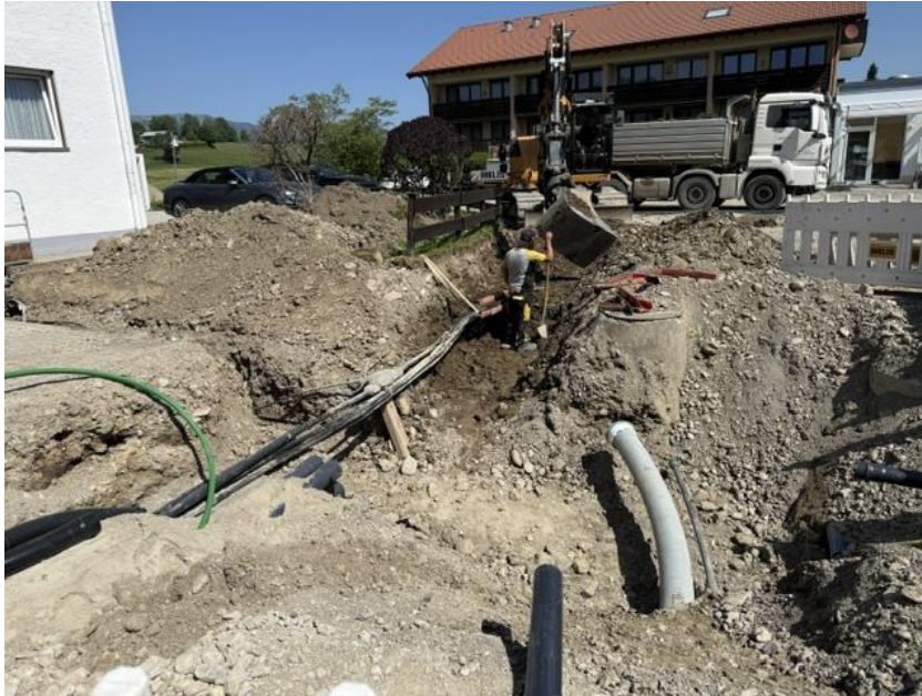
Verlegung der Leitungen AÜW, Telekom, Wärmenetzleitung am 26.05.2026
