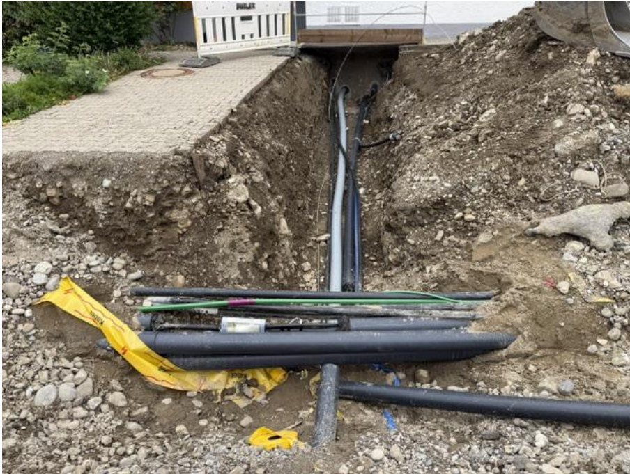
Verlegung der Hausanschlüsse am 02.06.2026
