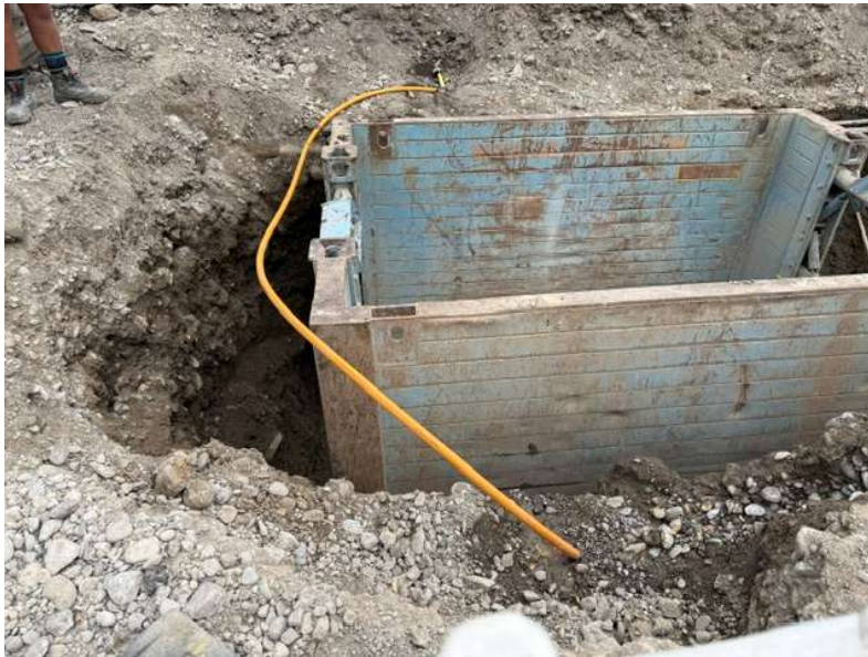
Verlegung Erdgas Hausanschluss
