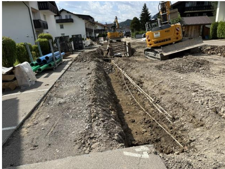
Voraushub Versickerrigole – auf Grund vorhandener Kabel und des MW- Kanal ist das Versetzen ab hier nur in offener Bauweise möglich (Verbau nicht zu stellen)
