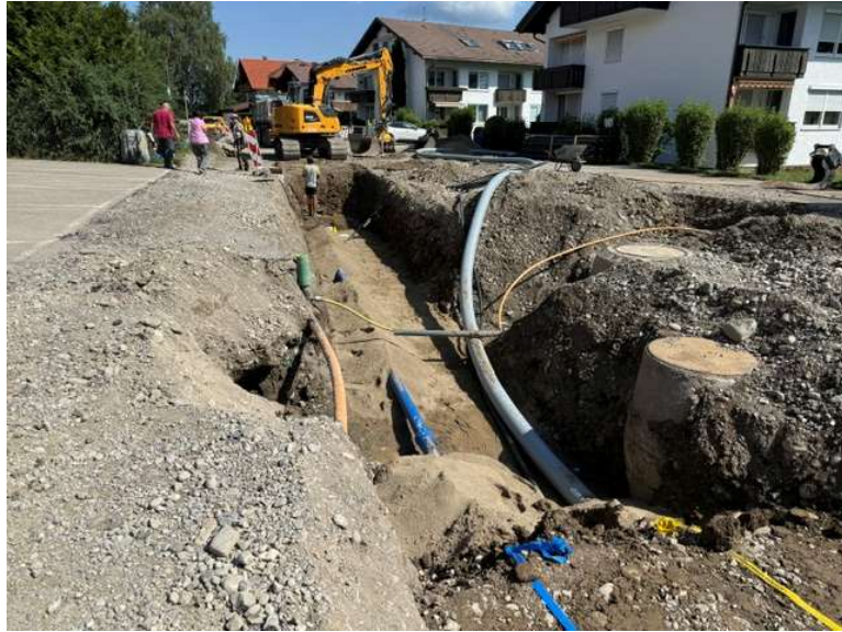
Verlegung Wasserleitung und Fernwärmeleitung (parallel auch die Hausanschlussarbeiten)
