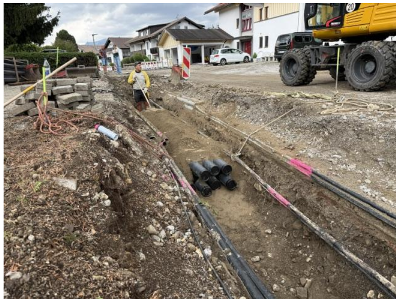
Verlegung Kabelpaket
