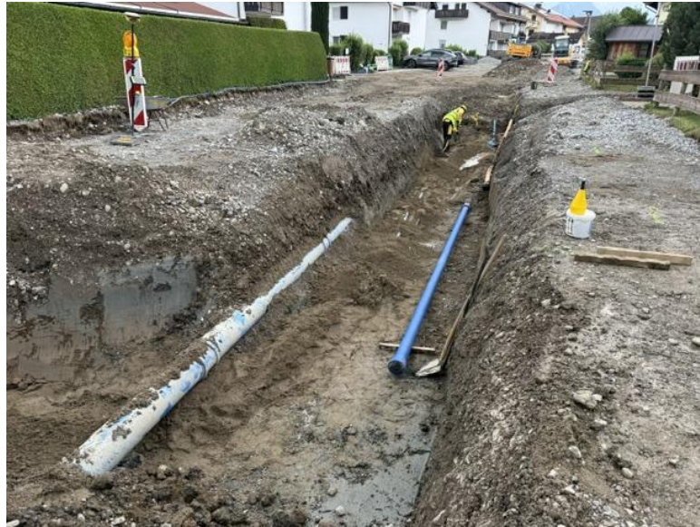
Verlegung Hauptwasserleitung
