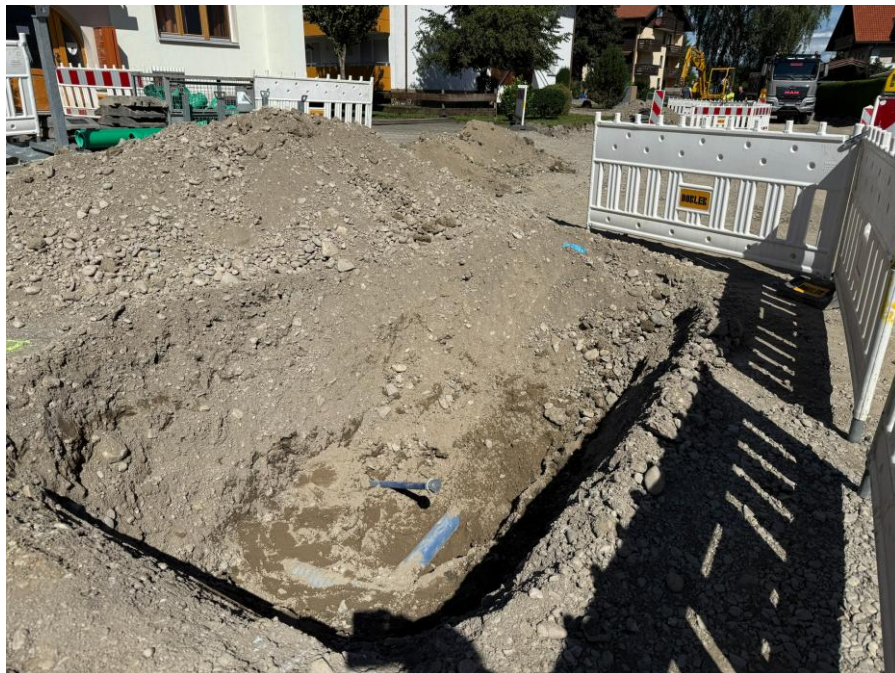
Vorbereitung zum Umschluss Wasserleitungshausanschluss
