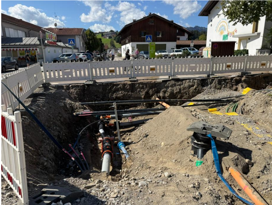
Vorbereitung zur Kreisstr.querung aus der Grünenstr.
