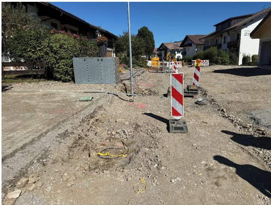
Beginn Absteckung Linienpflaster
