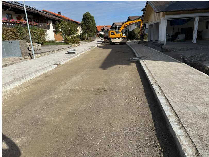
Vorbereitung der Asphaltierung
