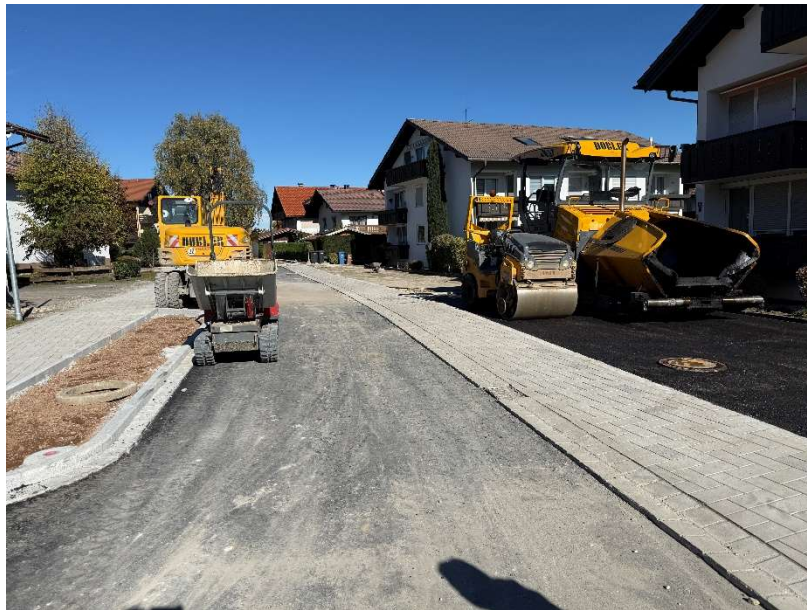
Arbeiten an den Privatflächen
